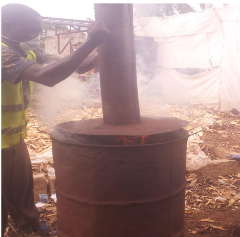
Photo 2: Pose de cheminée
