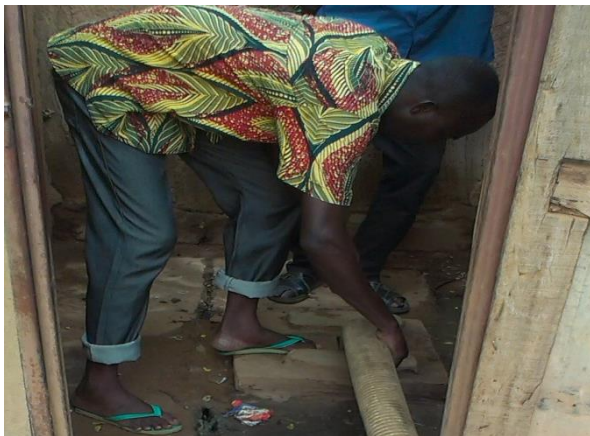
Photo 7: Absence d'équipements de protection
