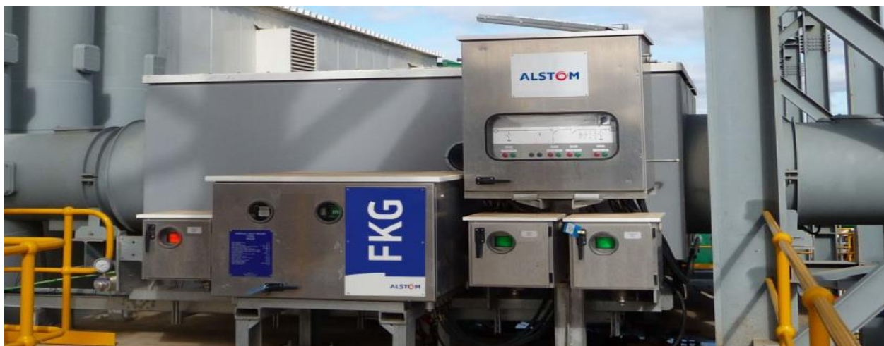
Figure 23 : Le disjoncteur 52G
