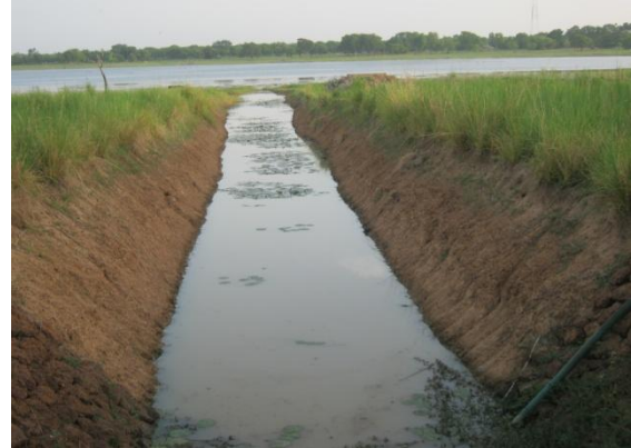
Canal d'améné d'eau (Mars 2012)
