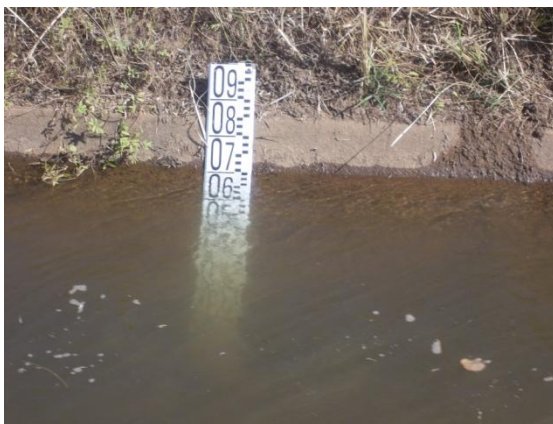
Canal primaire avec la vanne ouverte (Nov. 2013)
