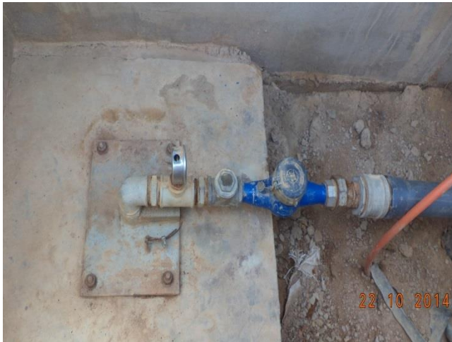
Figure 3 : Vue de la tête du forage
