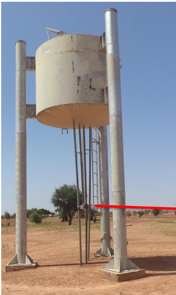
Figure 6 : Vue d'ensemble du réservoir surélevé
