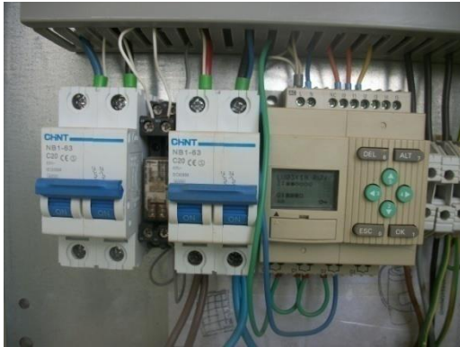
Figure 15 : Vue du Variateur de tension
