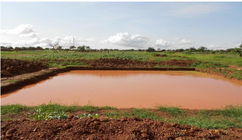
Photo 9. Bassin à fond et parois non imperméabilisés sur un sol latéritique à Tougou, province du Yatenga en zone sahéenne
