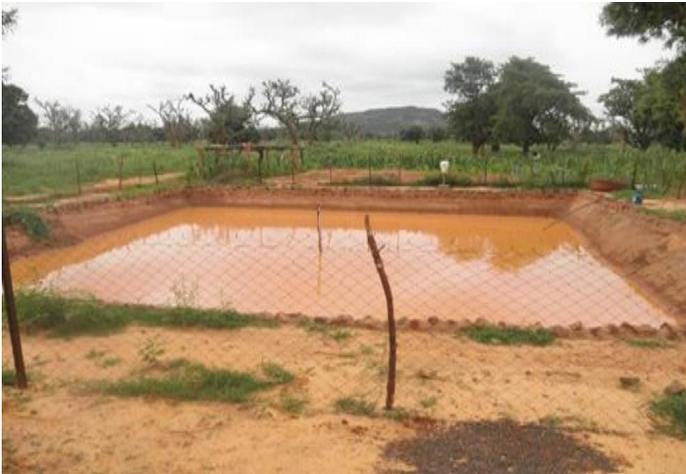
Photo 10. Bassin à fond imperméabilisé en argile et parois imperméabilisées en ciment dans le village de Mogodin, province du Bam en zone sahélienne
