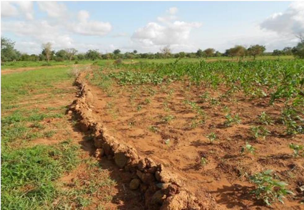
Photo 3. Mise en place des cordons pierreux dans une exploitation agricole
