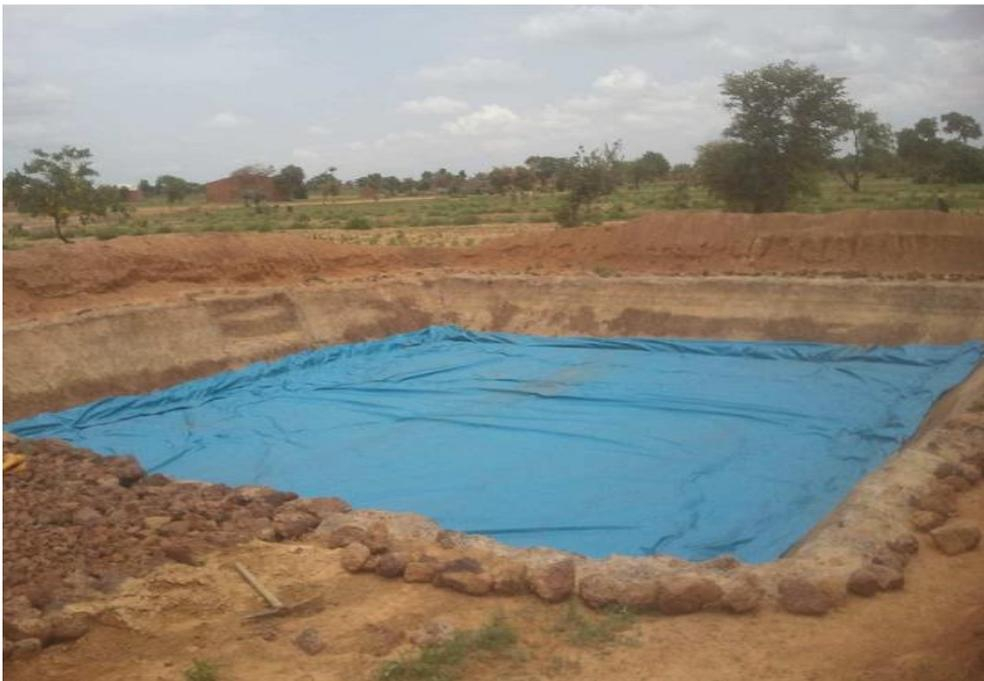
Photo 11. Bassin à fond bâché et parois imperméabilisées en ciment dans le village de Sologom, province du Yatenga en zone sahélienne.
