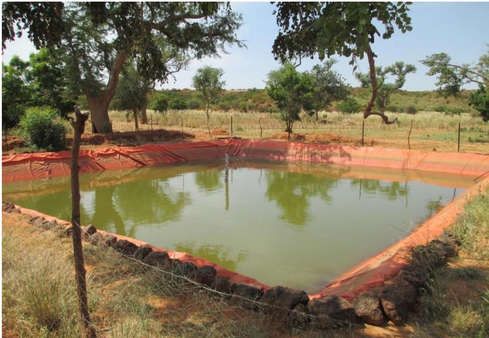
Photo 12. Bassin à fond et parois imperméabilisés à partir d'une bâche sur un sol sableux dans le village de Mogodin, province du Bam en zone sahélienne
