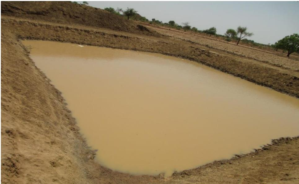
Photo 8. Bassin à fond et parois non imperméabilisés sur un sol argileux dans le village de Sandouré, province du Bam en zone sahéenne
