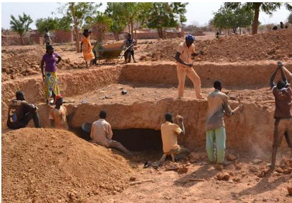
Photo 5. Excavation d'un bassin à partir de la main-d'œuvre familiale
