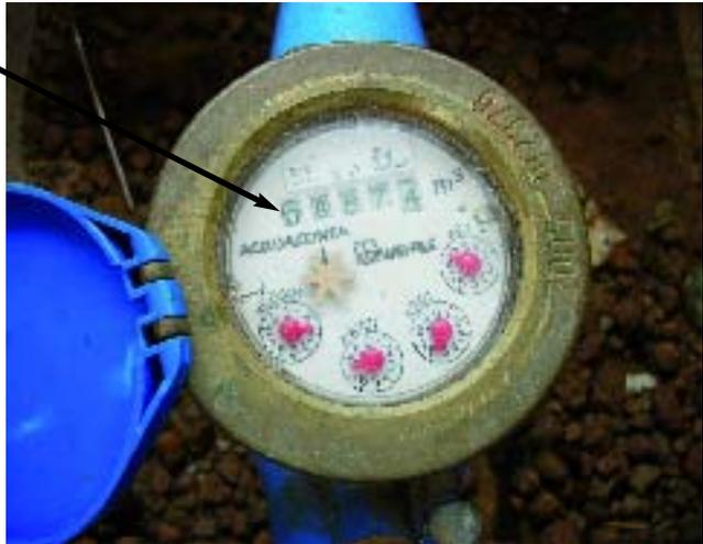
La différence des 2 index relevés à la même borne-fontaine à des temps différents, correspond à la consommation d'eau durant le temps écoulé entre les 2 relevés.
