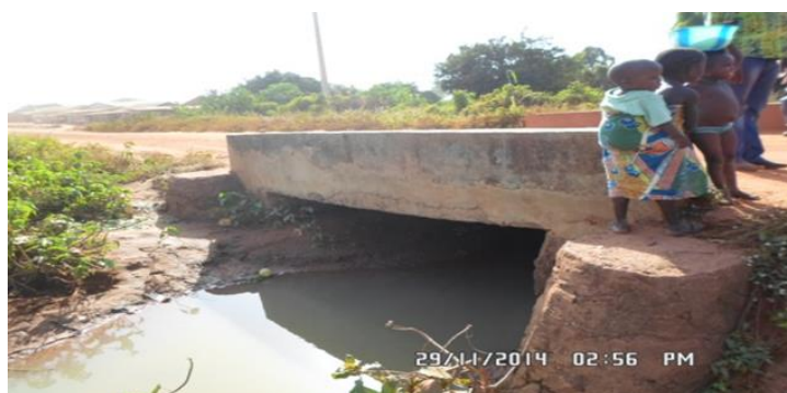
FIGURE 4: OUVRAGE PK 7+900 DALOT A PIEDROIT EN MAÇONNERIE DE MOELLONS
