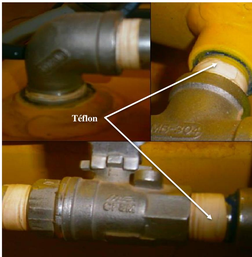
Figure 11 : Quelques pièces raccordées en utilisant du téflon.
