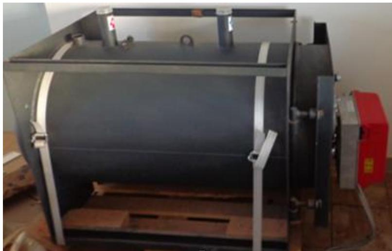
*Figure 12 : Chaudière GARIONI NAVAL de la plateforme.*
