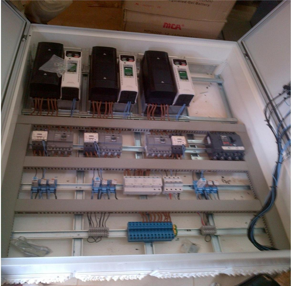
Figure 15: Armoire de commande câblé (périmètre 500 SP1)
