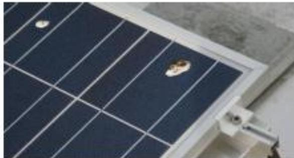
Figure 1 : Déchets d'oiseaux sur le module PV [1]
