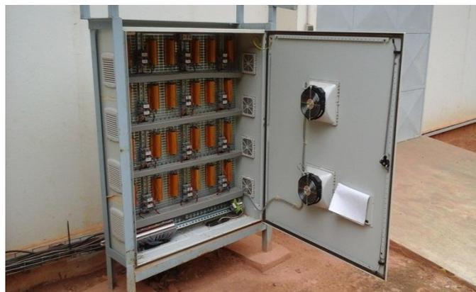
Figure 11 : Armoire des charges résistives
