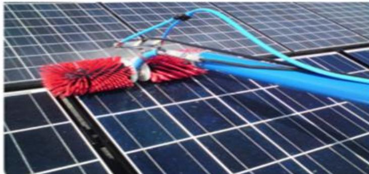
Figure 5 : Nettoyage des modules PV par injection d'eau[9]
