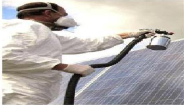
Figure 6 : Nettoyage de module PV avec photocal SC[11]
