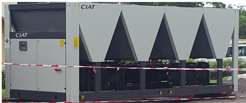
Figure 5 : Centrale à eau glacée CIAT
