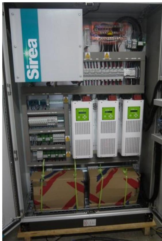
**Figure 16: Armoire de 9 kW d'EDM**
