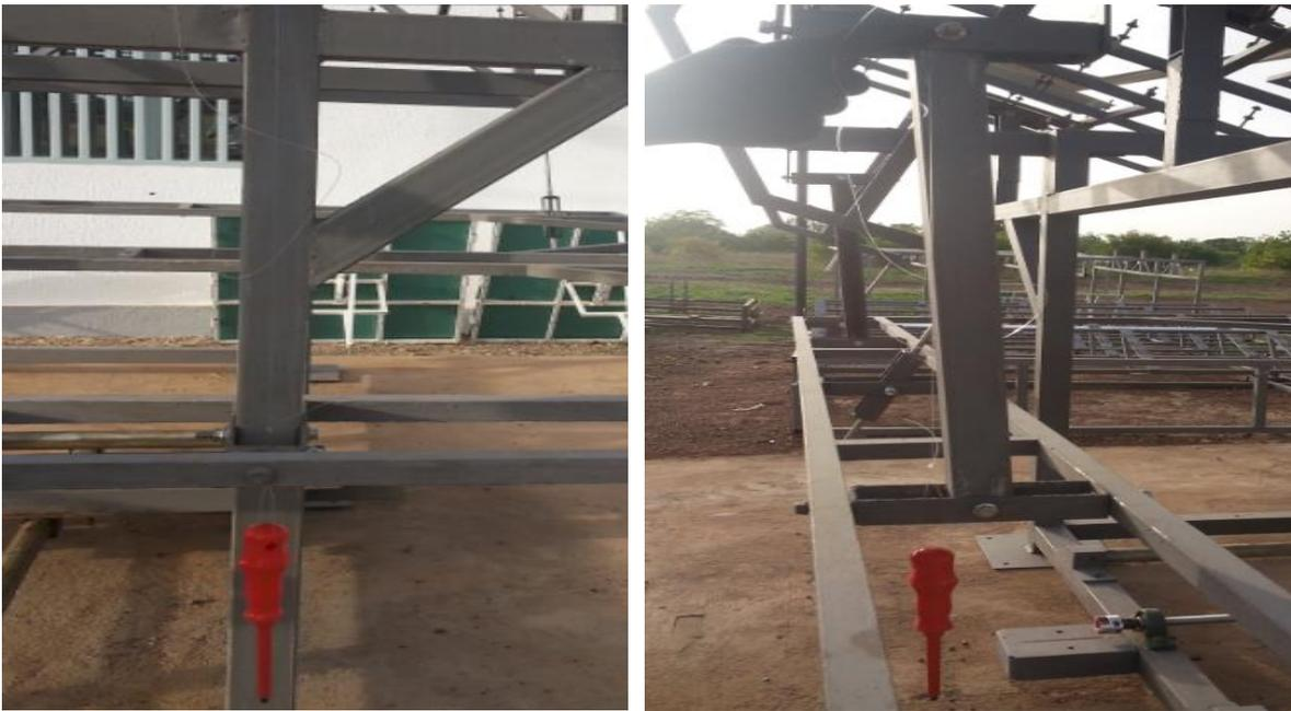
*Figure 26 : Image illustrant la détermination de la verticalité des bras*
