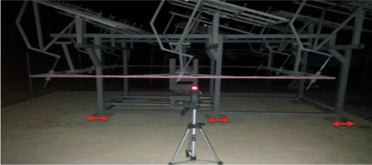
*Figure 24 : Ajustement de l'héliostat suivant l'axe horizontal*
