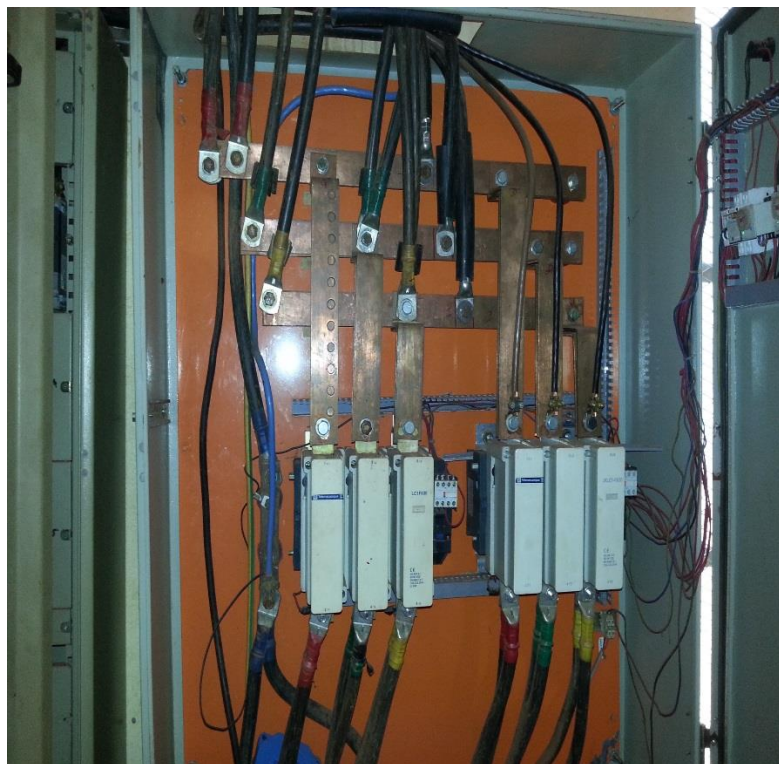
Figure 2 : Armoire arrivée TGBT
