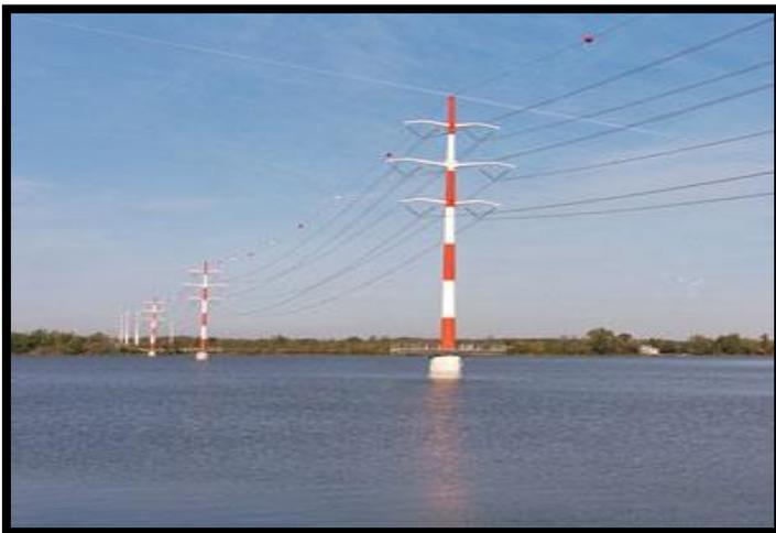
Figure 6 : Pylône tubulaire d'alignement
