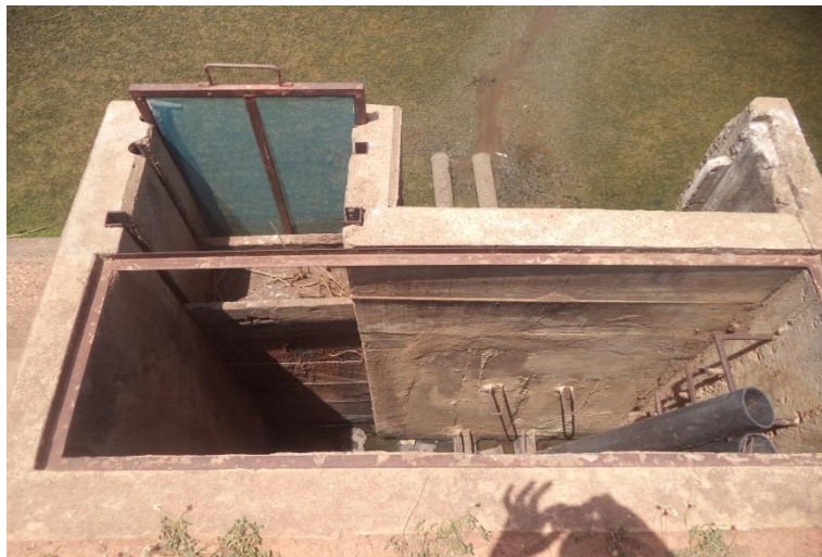
Figure 5 : Vue d'un moine avec ses éléments constitutifs
