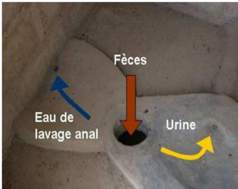
Figure 9: Modèle de séparation traditionnelle en béton (Source CREPA, 2010)
