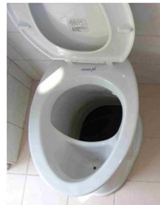
Figure 11: Modèle de séparation moderne (Source CREPA, 2010)
