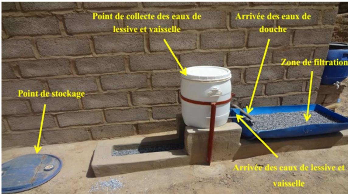
Figure 17: Traitement par bacs inclinés (Source : TOLGOURO, 2013)
