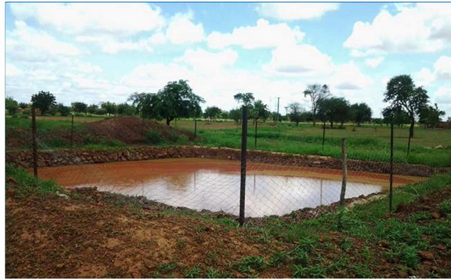
Figure 19: Bassin de collecte des eaux de ruissellement (Source : Diarra et Al. 2015)
