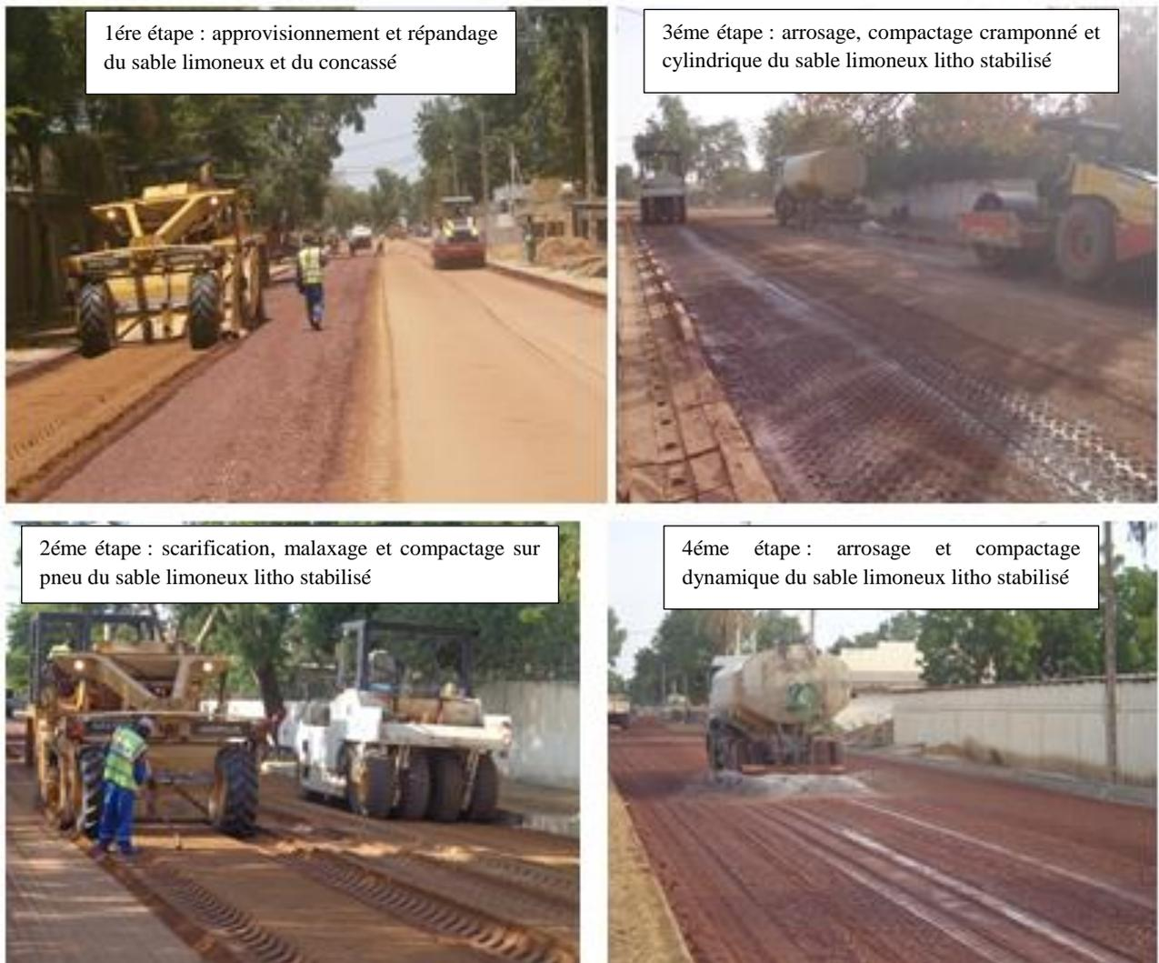
Figure 3 : la mise en œuvre de la lithostabilisation
