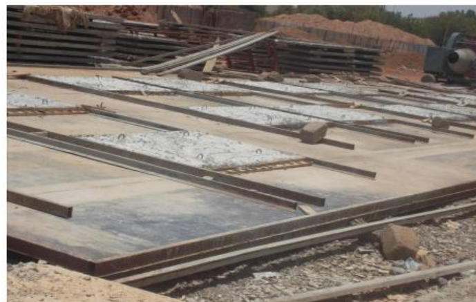
Figure 4 : poste de préfabrication des prédalles
