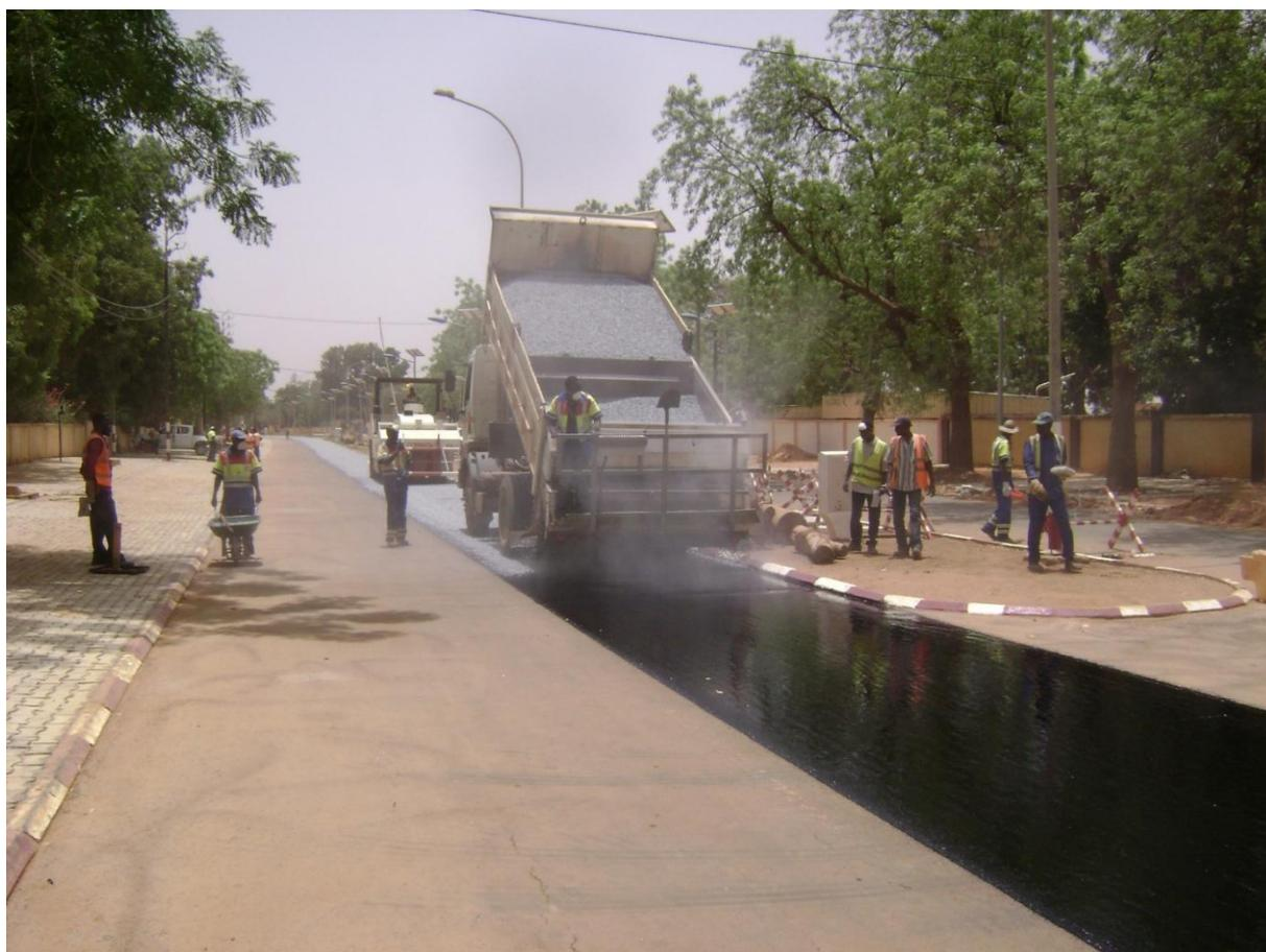
Figure 8 : Gravionnage mono couche
