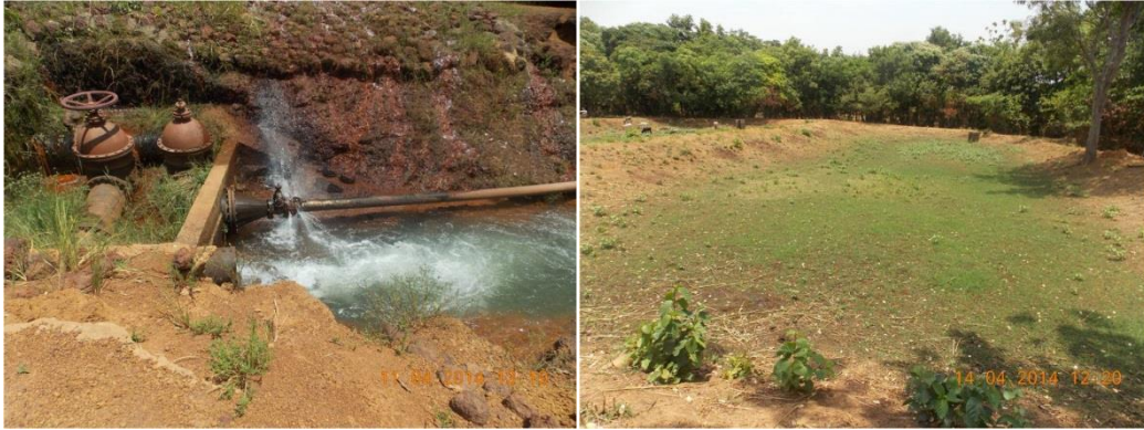
Photos 4: Ouvrage de prise constitué de deux vannes et bassins de pisciculture
