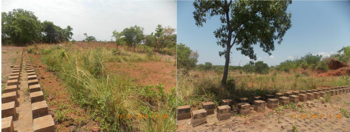
Photos 7: Deux rangées de blocs chicanes suivies d'un vide où se développent une végétation herbacée et des arbres
