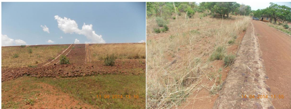
Photo 3 et 8 : Escalier d'accès et descente d'eau sur le talus aval et Présence d'herbes sur le talus aval
