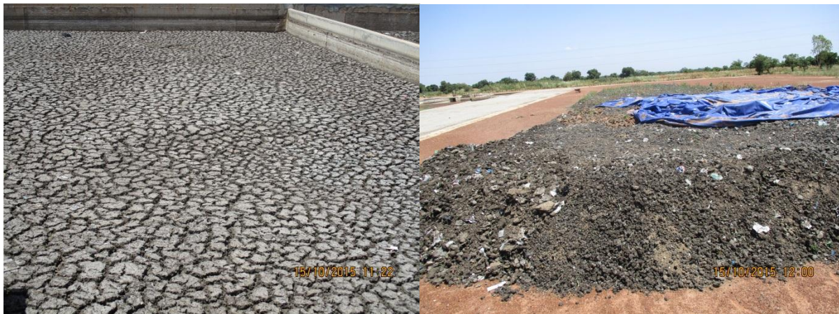
Figure 9 : Photo des boues de vidange séchées sur lit et d'un tas de bio-solides
