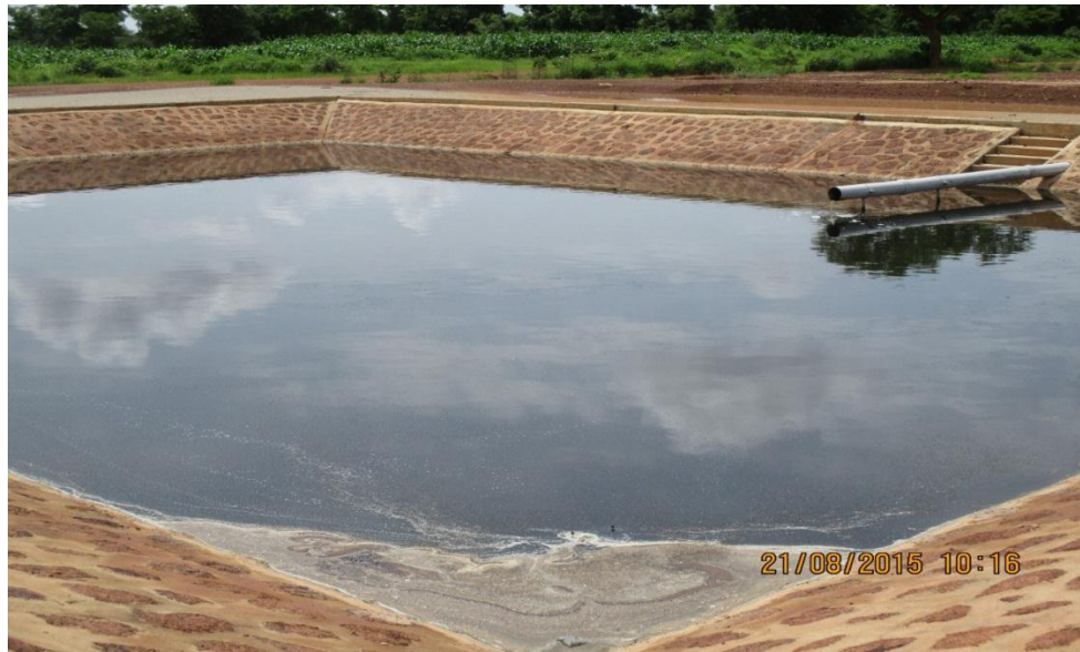
Figure 11 : Photo du bassin anaérobie de la STEP de Zagtoui
