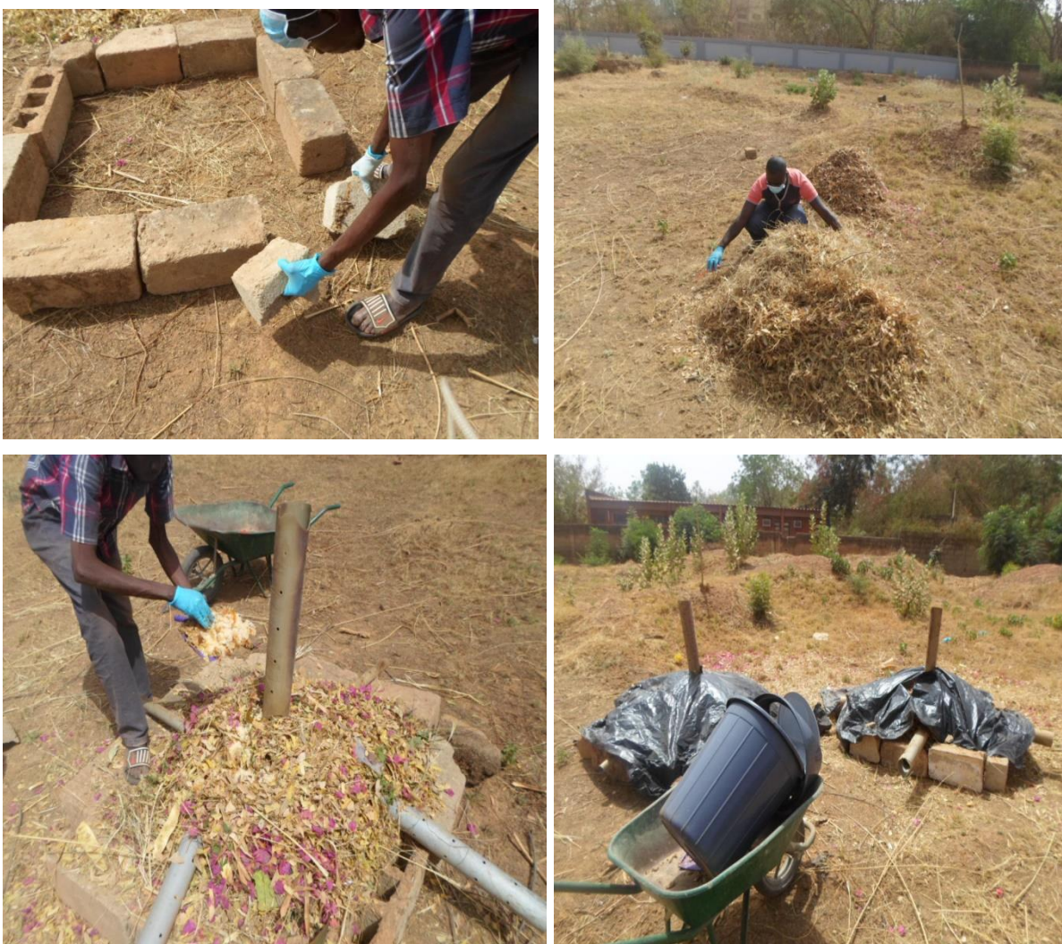
Figure 7 : Images de la mise en place des andains
