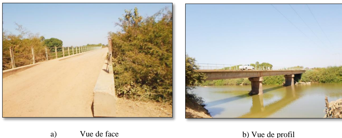
Figure 2: Vues sur ouvrage existant
