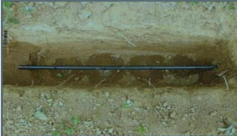
Figure 7 Mode de pose ligne de goutteur (IRSTEA, 2013)
