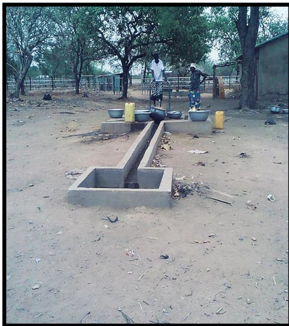
**Photo 5:Forage à hydro pompe vernier**
