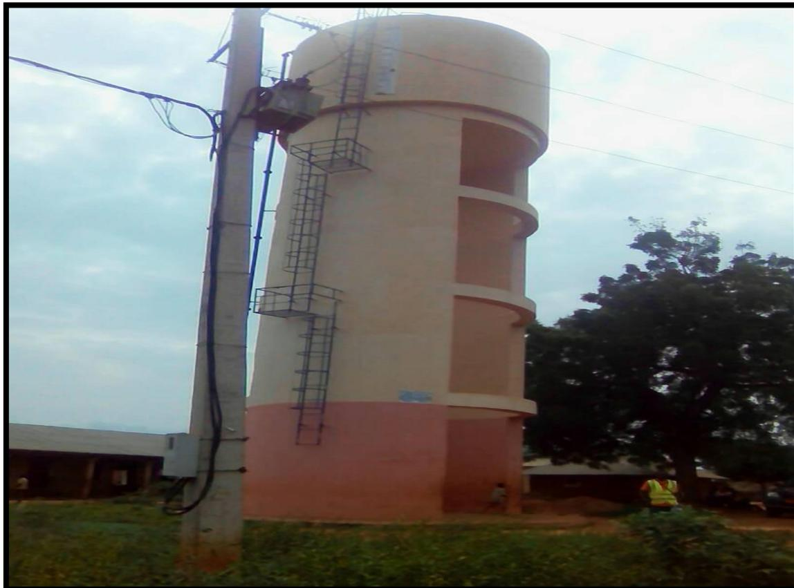
**Photo 3 : Exemple type de Château d'eau cylindrique arque**
