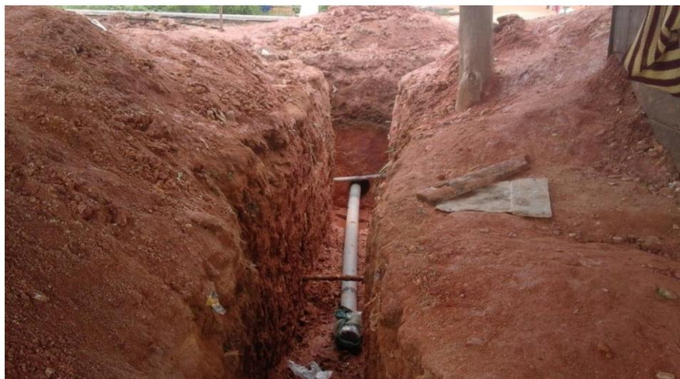
Figure 6: Traversée de chaussée par fonçage horizontal et pose de fourreau à Gblétia
