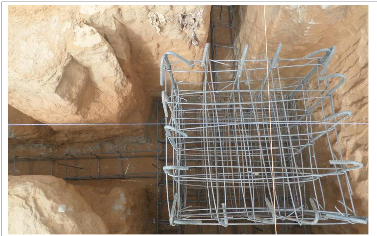
**Figure 6: Ferrailage de la fondation du château**
