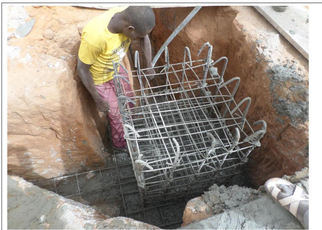
**Figure 7: La mise en œuvre de la fondation du château**
