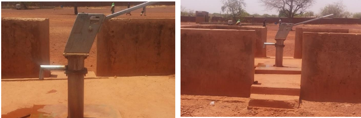
Figure 3 : Photos du forage du CMA de Gourcy.
