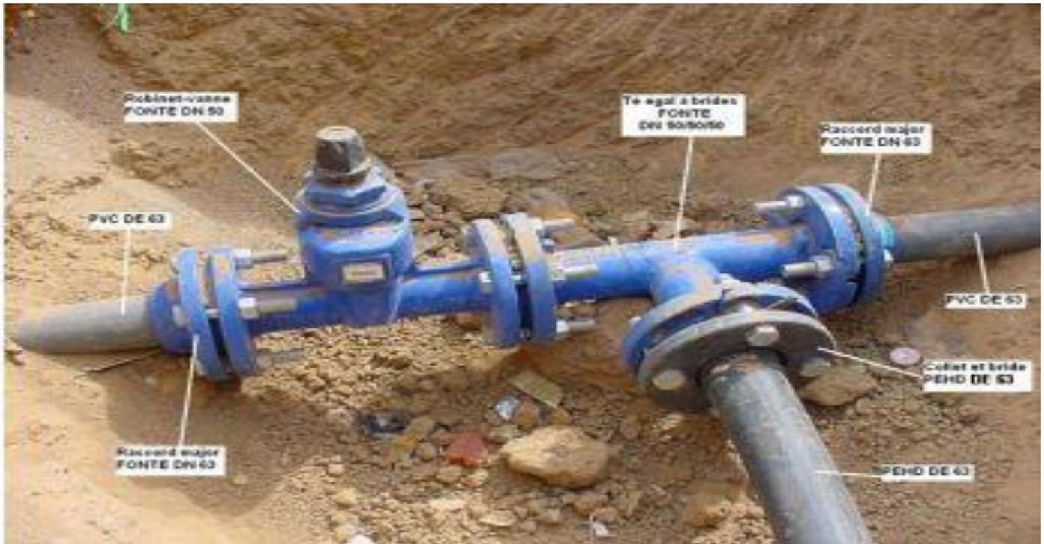
Figure 13: Utilisation de pièces en PEHD pour la composition d'un nœud.
