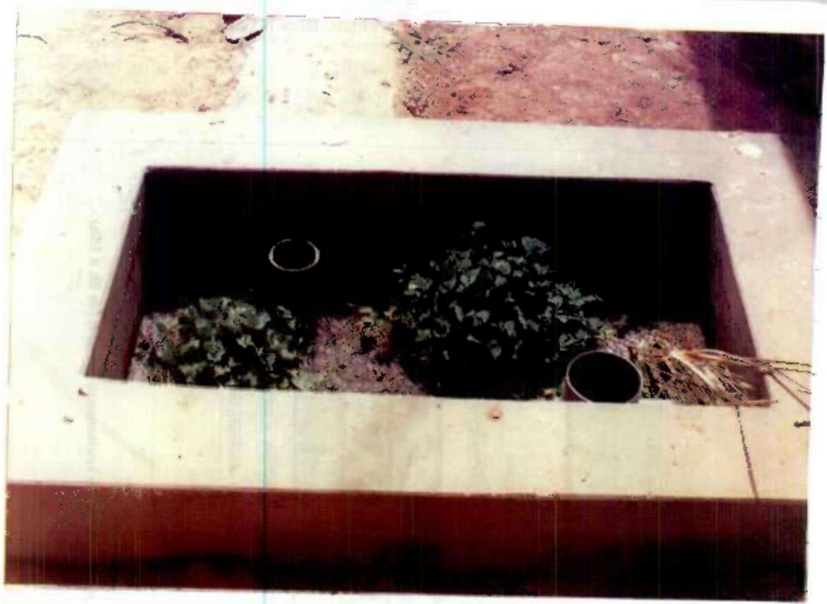
*Photo 1 : Le décanteur-digester avec la croûte plantée en Marseille.*
