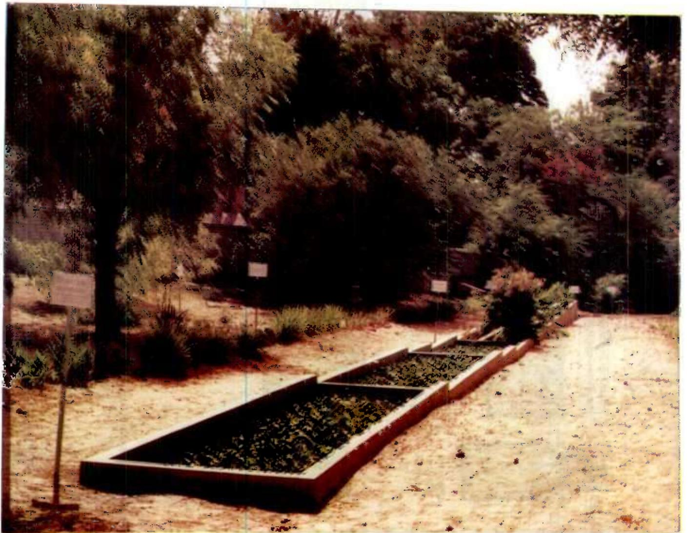
*Photo 2 : Vue d'ensemble du lagunage à macrophytes. Au 1<sup>er</sup> plan les 3 canaux en série de l'épuration secondaire. Au second plan les 3 canaux en parallèle pour l'étude de l'épuration tertiaire et notamment de l'abattement bactérien.*
