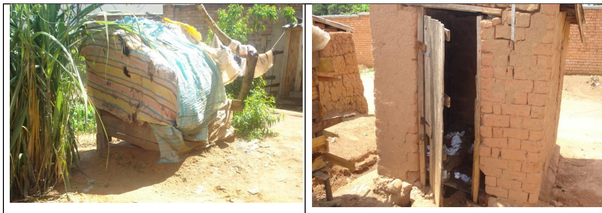
Figure 21. EXEMPLE DE DOUCHE (A GAUCHE) ET DE LATRINE (A DROITE) UTILISEES PAR LES TRAVAILLEURS INFORMELS N'AYANT PAS UN LOGEMENT A LA CITE AKAMASOA
