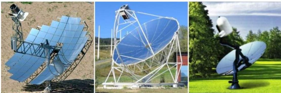
Figure 11 : les systèmes parabole/Stirling de gauche à droite SunCatcher, Eurodish et Sunmachine [10]
