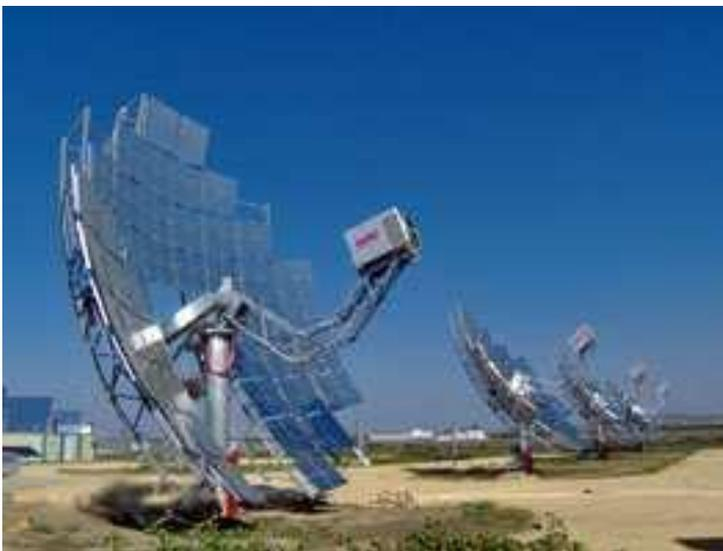
Figure 9 : Centrale de 8 unités parabole/Stirling installée par Abengoa [9]
