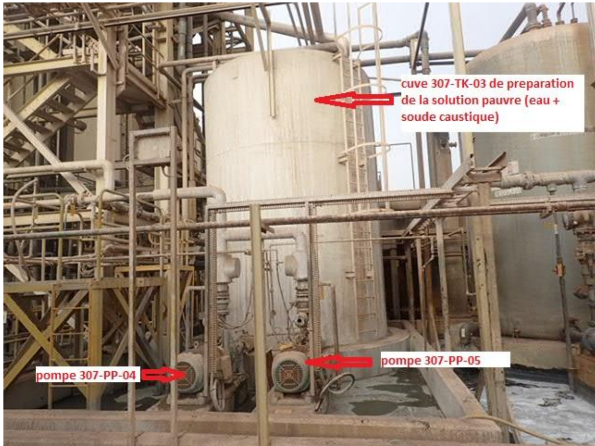
Figure 4: Présentation des pompes 307-PP-04 et 307-PP-05
