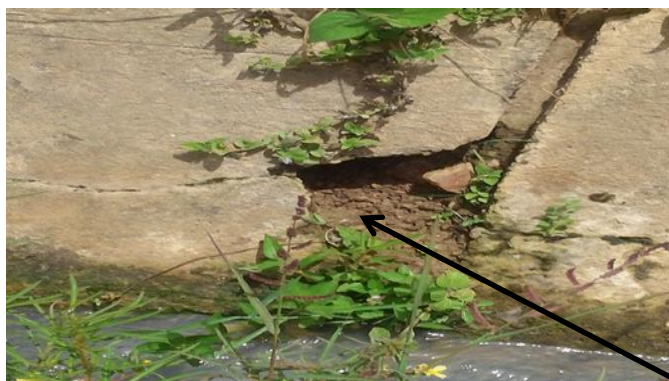
Figure 10:Fissure sur un canal tertiaire
