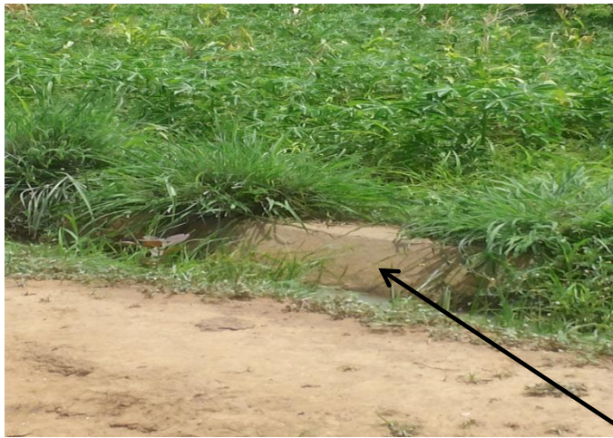
Canal tertiaire Enherbé
