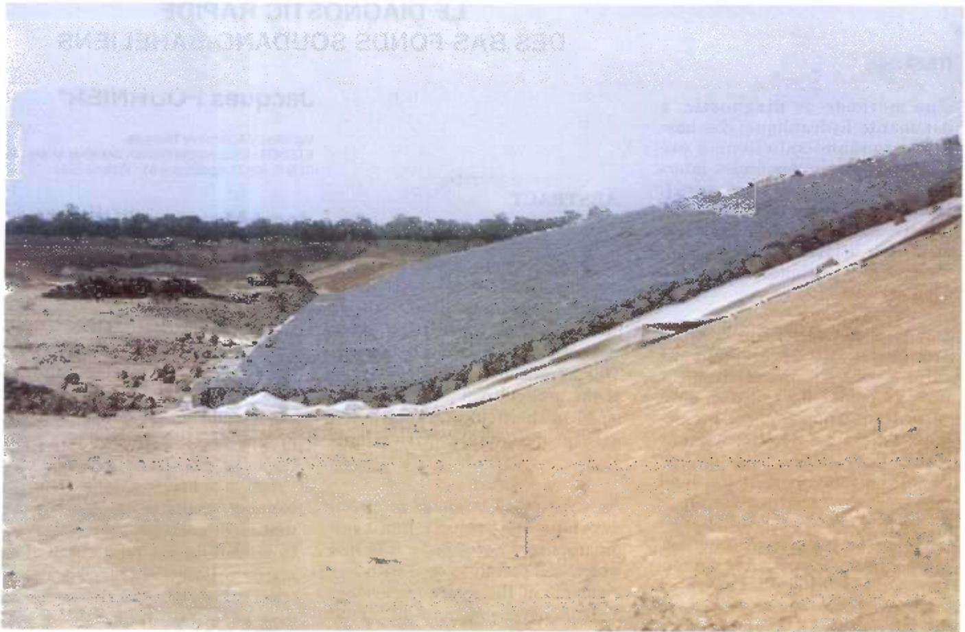
*Photo n°2 : Protection du parement amont en matelas Reno en cours de réalisation*
