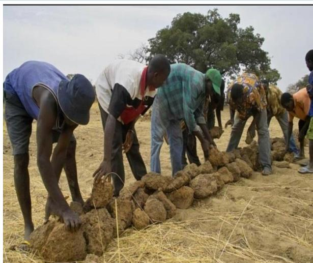
**Photo 5:** Mise en place d'un cordon pierreux
