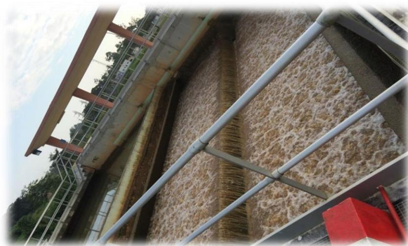
**Figure 5 : Lavage des filtres à sable de la station de traitement NTM 3- 4**
