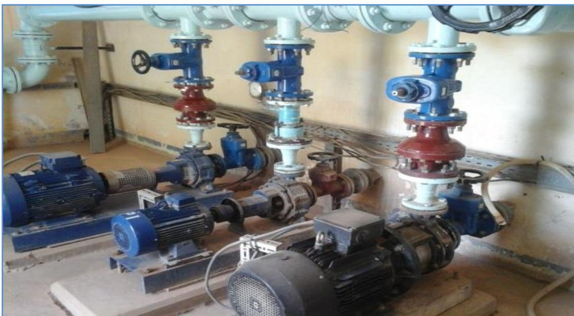
Figure 2: Pompes de refoulement des eaux de la bache
