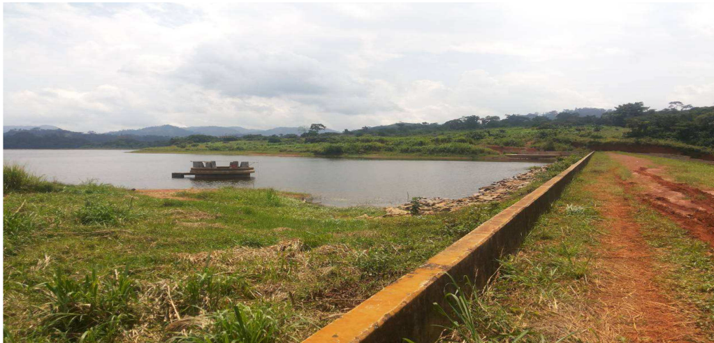
Annexe 1: Barrage de la MEFOU
