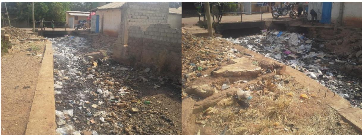
Figure 7. Bouchage d'un canal d'évacuation des eaux par les déchets solides à Zongo.
