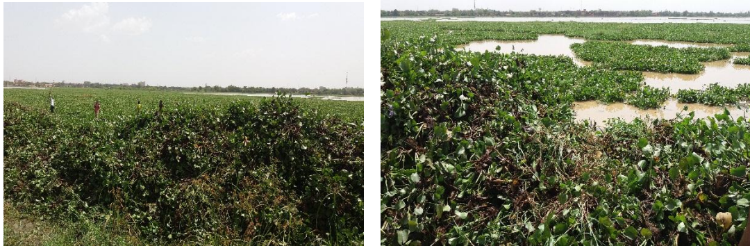
Figure 6: L'état du barrage n°2
