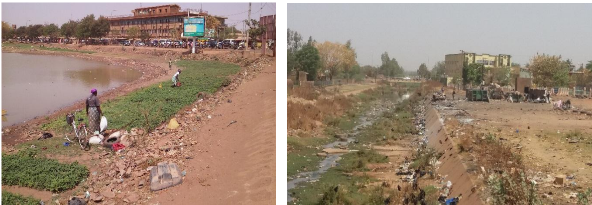
Figure 8: les activités autour du barrage n°2 et l'état des affluents
