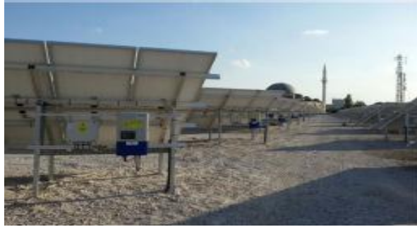
Figure 5: configuration 1 : onduleurs décentralisés
