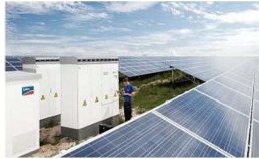
Figure 6: configuration 2 : onduleurs centraux
