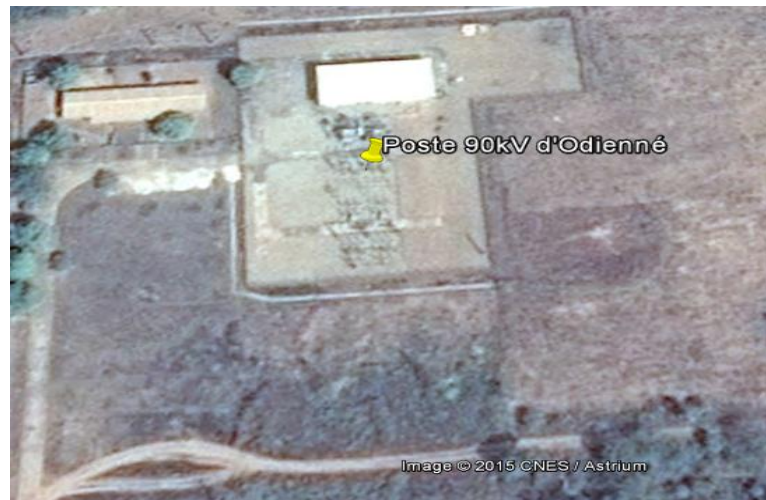
Figure 3: Poste 90/33 kV d'Odienné [5]
