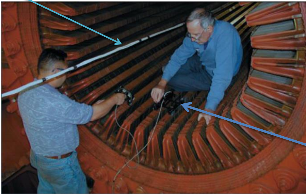
Figure 20 : Test d'EL CID sur un alternateur (15)
