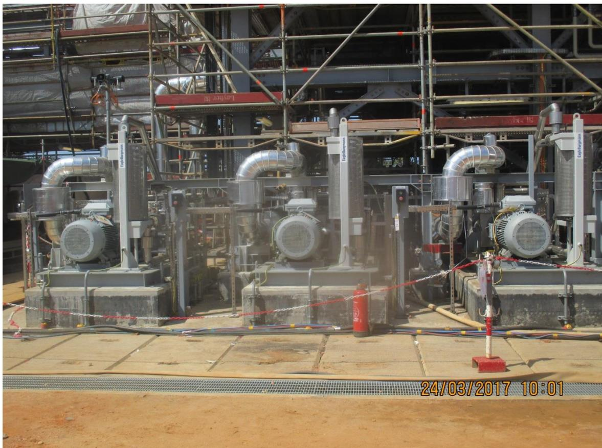
*Figure 4: Pompes de circulation d'eau chaude*
