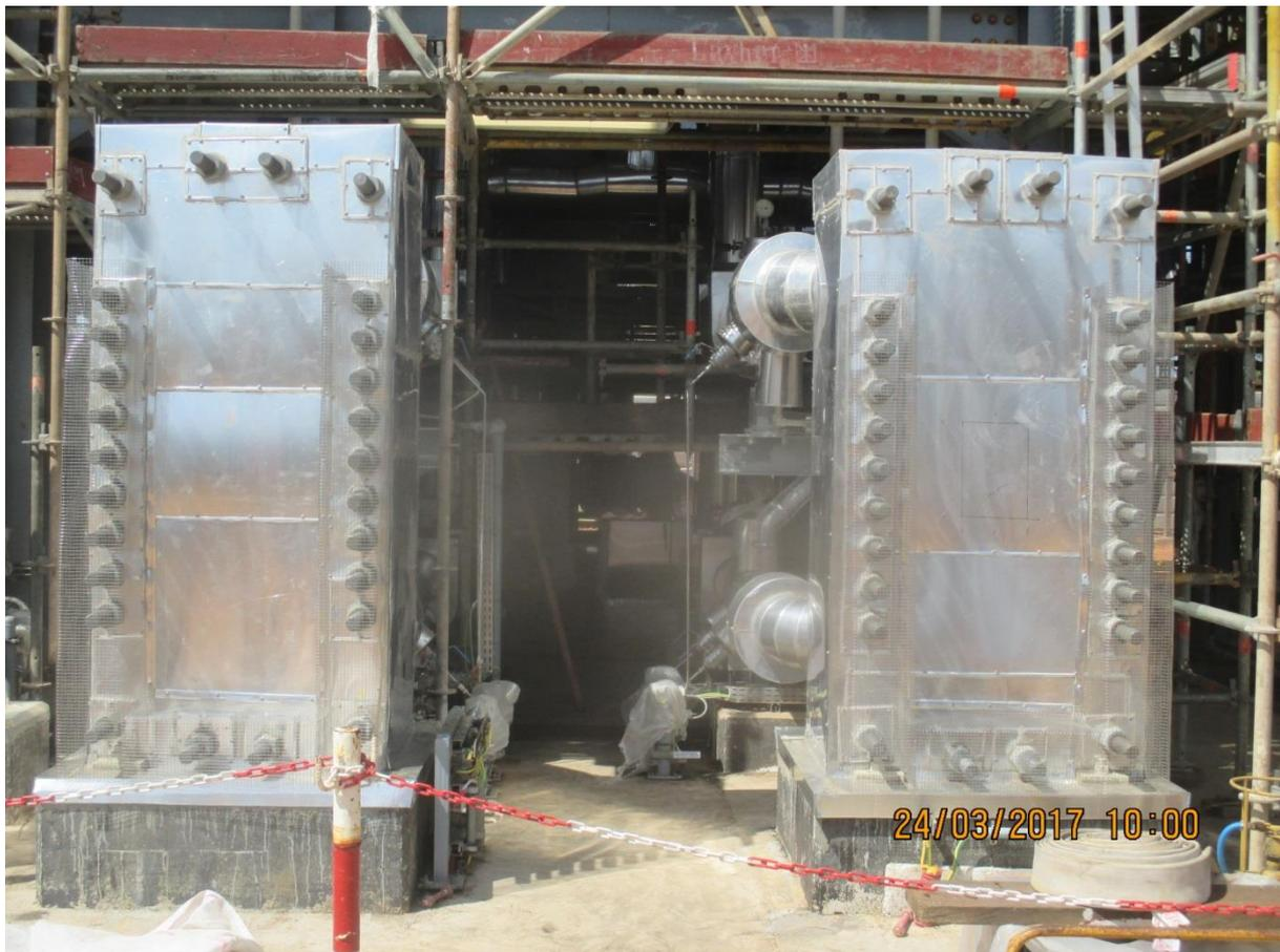
*Figure 5: Les échangeurs à plaques*
