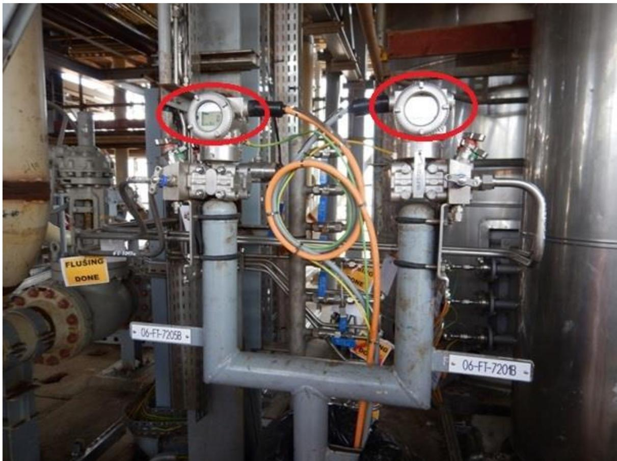
*Figure 14: Mauvais montage des débitmètres*
