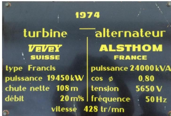
*Figure 5 : Caractéristiques électriques du groupe turbo-alternateur de 24 MVA*
