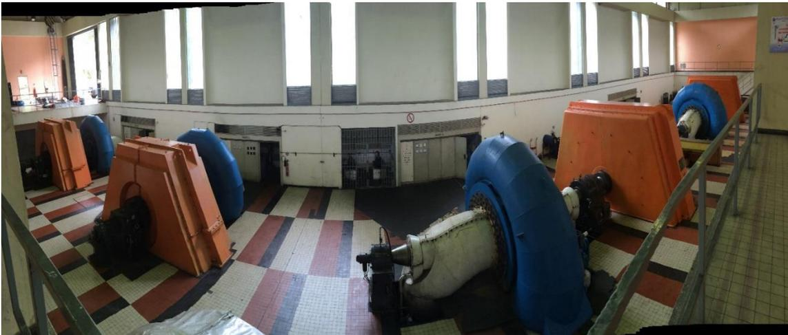
*Figure 4 : Photographie des 4 groupes turbine-alternateur de la centrale*
