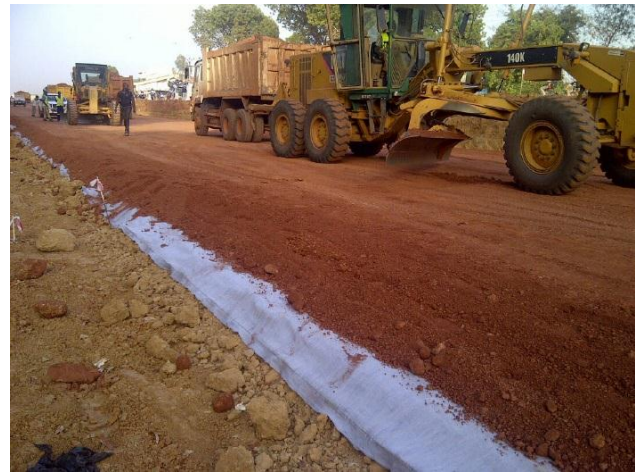
Figure 24 : Phase de remblayage sur le géotextile
