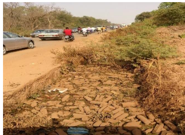
Figure 12: Réseau de drainage existant côté droit vers le canal Zogona
