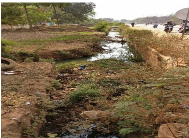
Figure 11: Réseau de drainage existant côté droit de la chaussée à proximité du carrefour Na ROUAMBA
