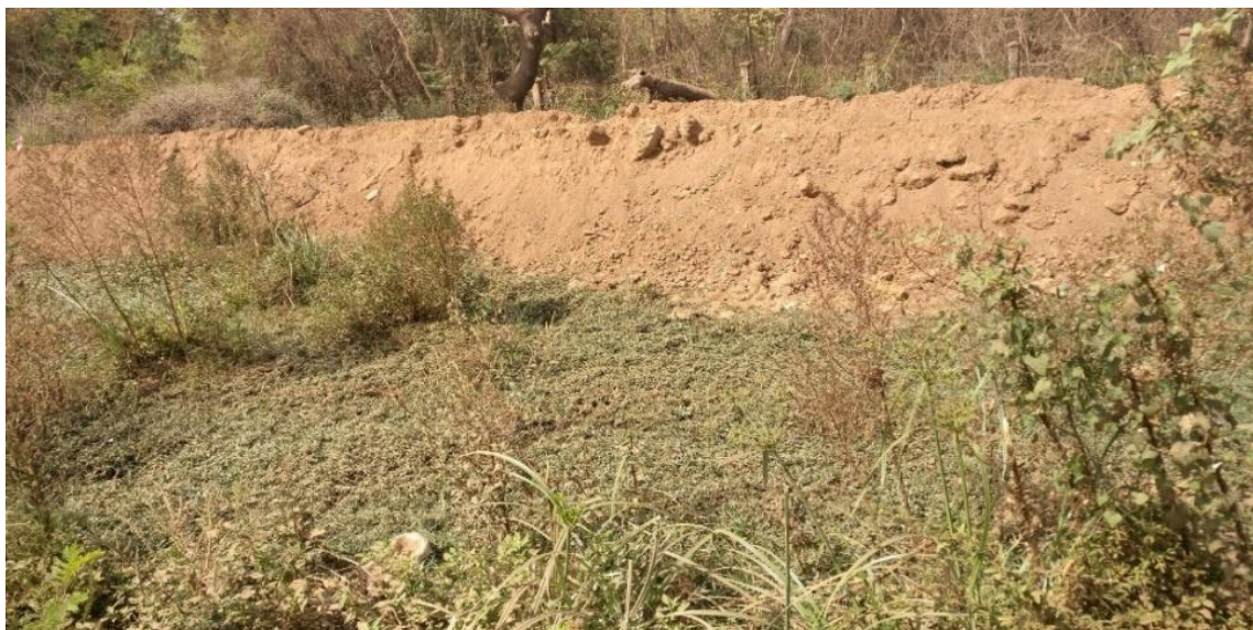
Figure 23: Rampes en remblai pour les essais
