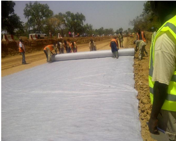
Figure 25: Mise en place du géotextile
