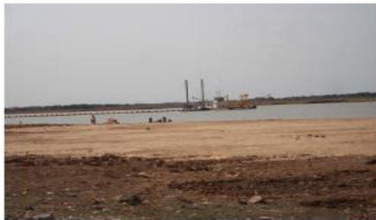
Photo 3 : Travaux de dragage au sud de la traversée par bac
