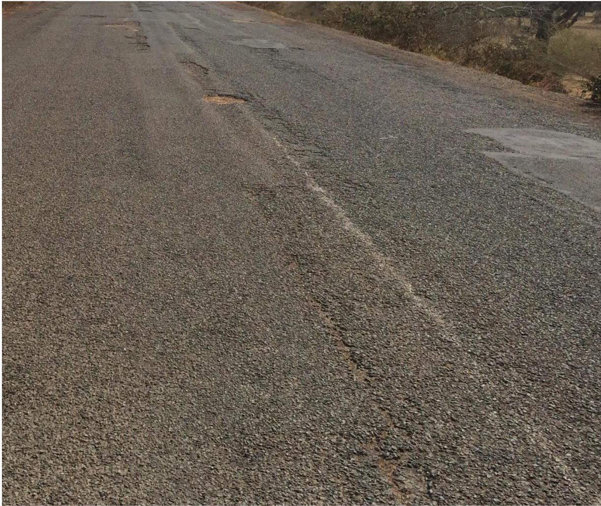
**Photo 2 : Arrachements de niveau 1 sur la chaussée**
