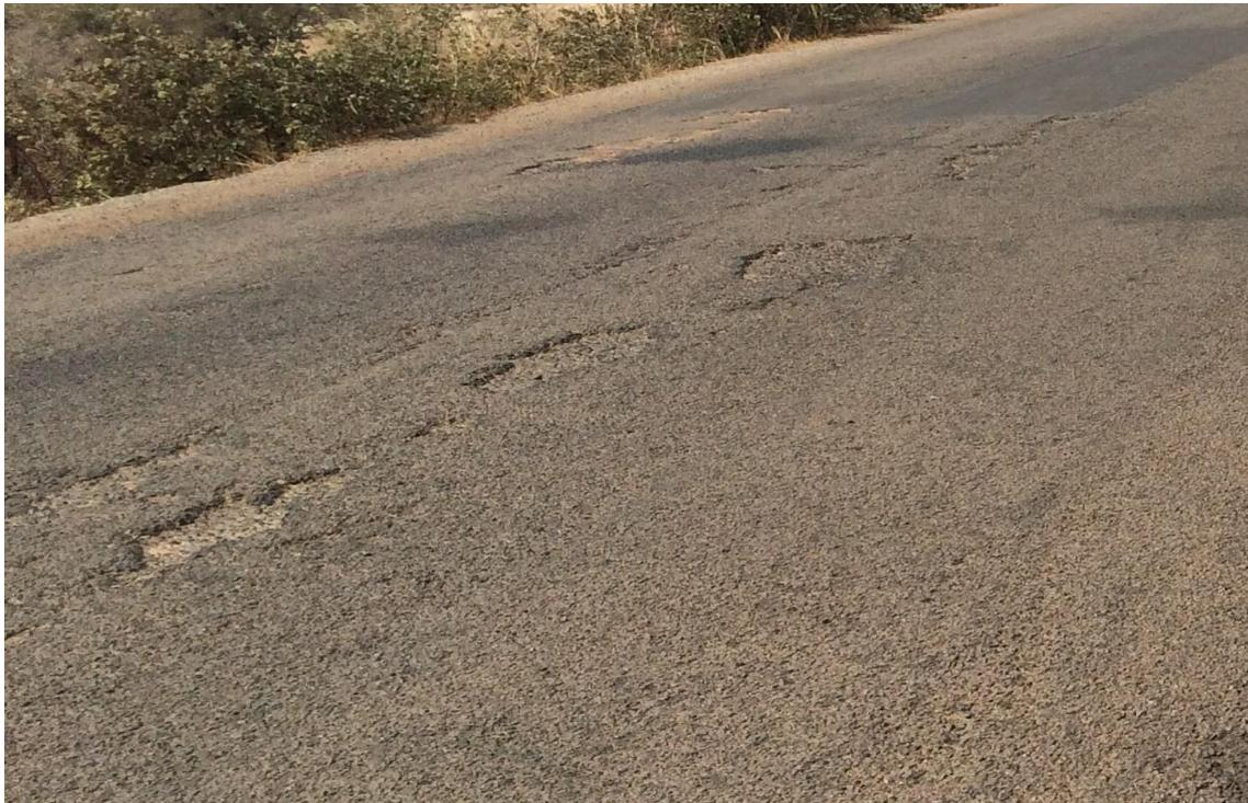
**Photo 1 : Arrachements de niveau 2 sur la chaussée**
